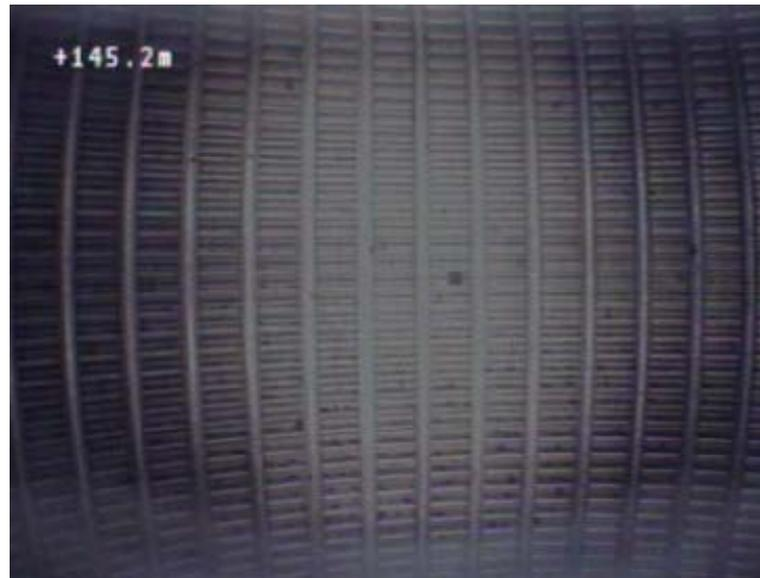
Fotografia de endoscopia – Exemplo de aplicação de tubo ralo sem aplicação de maciço drenante. Vista lateral.
