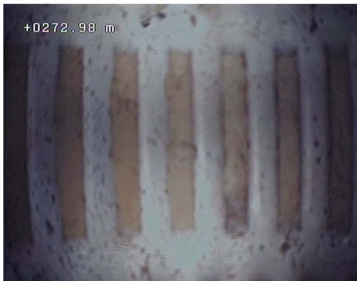
Fotografia de endoscopia – Pormenor de tubo ralo com rasgos em ponte, totalmente colmatados. Vista lateral.
