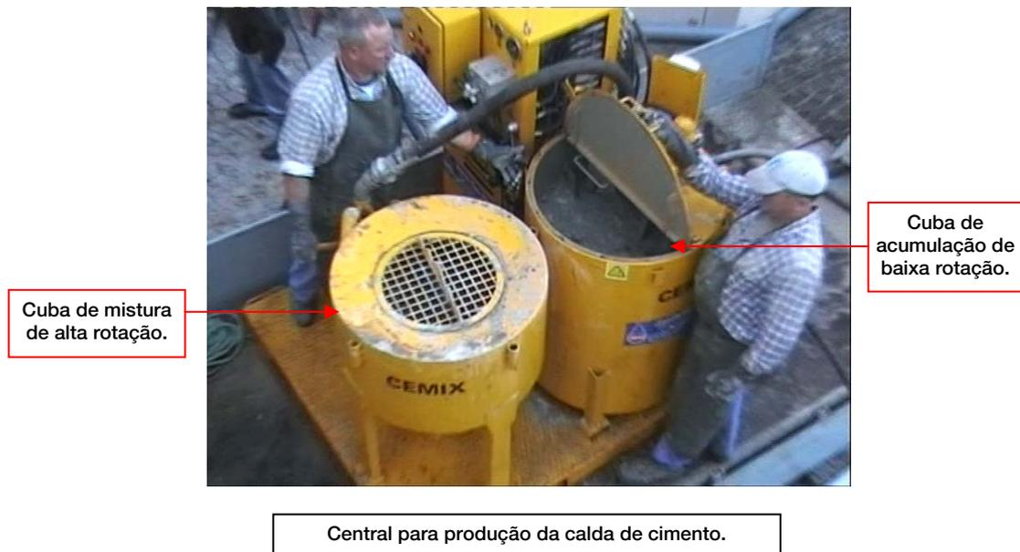
A preparação da calda, também designada por fase de amassadura, consiste na introdução do volume de água na quantidade pré-determinada no interior da primeira cuba, procedendo-se em seguida à introdução do cimento também na proporção desejada e, por fim, caso seja necessário, do adjuvante, ou dos adjuvantes, também nas quantidades pretendidas.
