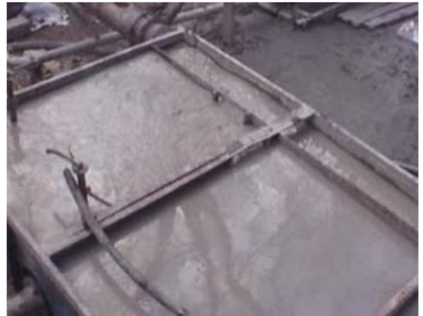
Tanques de recepção, separação e decantação de lamas
