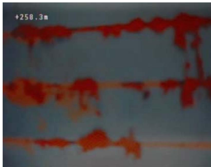
Fotografia de endoscopia – Rasgos de tubo ralo totalmente colmatado com acumulação intensa das lamias de estabilização. Vista lateral.
