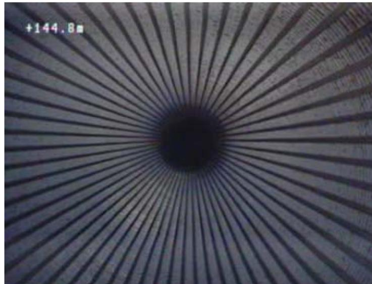
Fotografia de endoscopia – Segmento de tubo ralo de fio trapezoidal contínuo, em espiral, em aço inox, tipo Johnson, íntegro e limpo. Vista axial.
