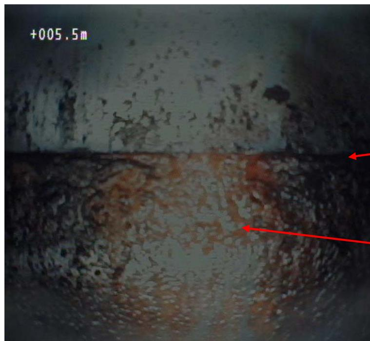
Junta entre troços da tubagem de revestimento
