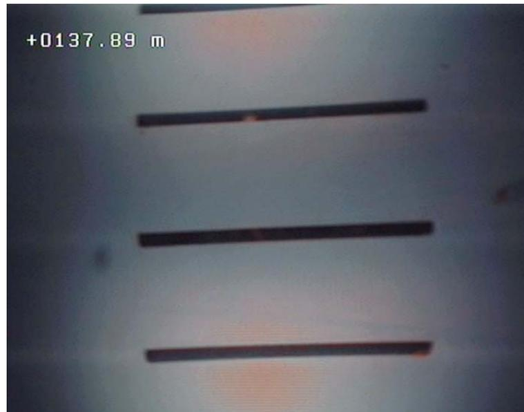
Fotografia de endoscopia – Tubo ralo com rasgos horizontais, em PVC, limpo. Vista lateral.
