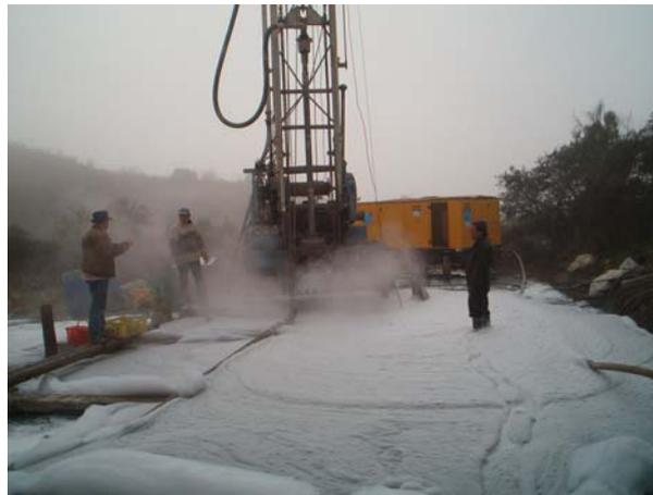
**Aplicação de espumas com ar comprimido**
