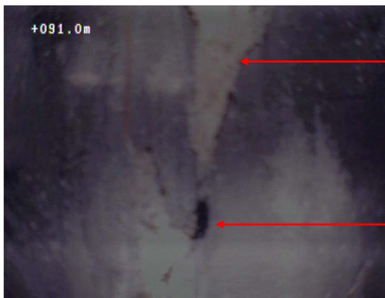
Intensa deposição de sais minerais devido a infiltração de água muito mineralizada.
