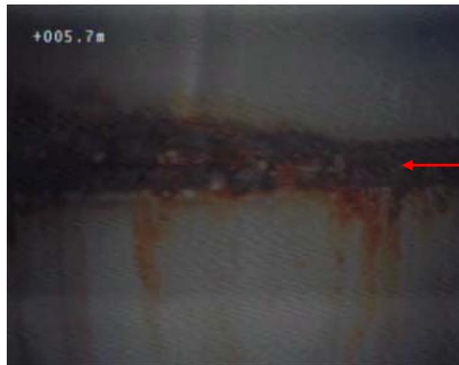
Soldadura da junta entre segmentos de tubo fechado, muito oxidada.
