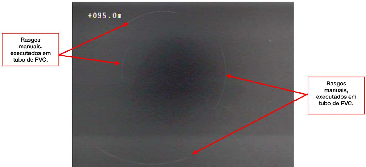
Fotografia de endoscopia – Ralos artesanais, executados manualmente, em tubagem de PVC. Vista axial.
