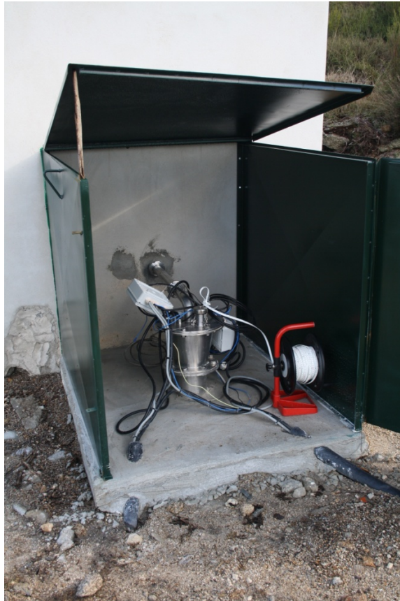
Figura 4 – Exemplo de um sistema de protecção de uma captação (foto gentilmente cedida por UNICER ÁGUAS, SA)
