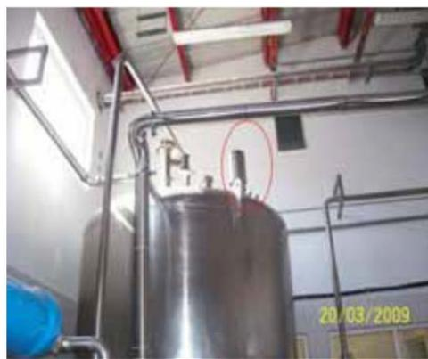
Exemplo de um tanque de armazenagem de água equipado com um filtro de ar
